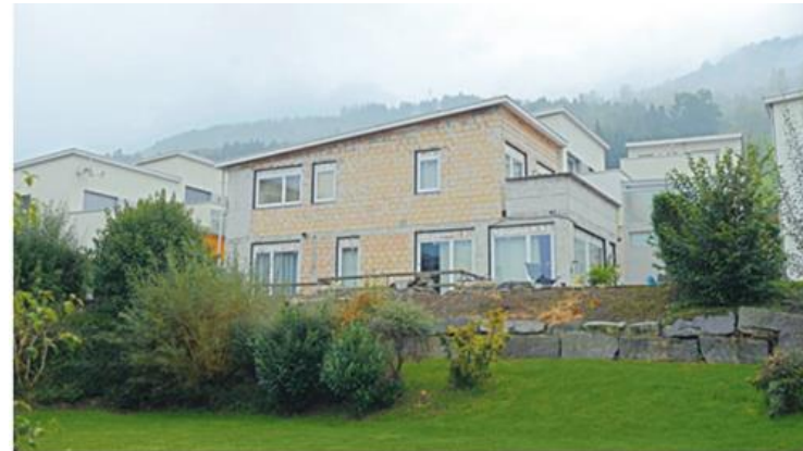
Wohnsitz im Rohbau – für ein Jahr dürfte der Hausbesitzer in eine andere Unterkunft ziehen.
