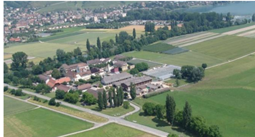
Massnahmenzentrum St. Johannsen/BE
