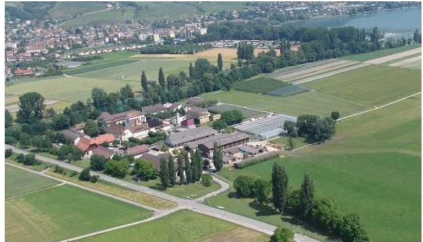
Massnahmenzentrum St. Johannsen/BE
